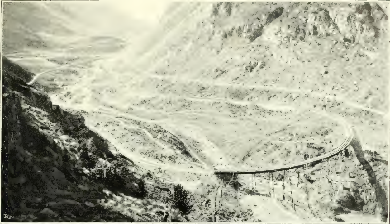
LES VOIES FERRÉES. — Non loin de Georgetown, la ligne gravit la montagne au moyen du fameux Loop (lacet), puis retourne en arrière et passe sur un pont élevé au-dessus de la voie qu'elle vient de parcourir.
